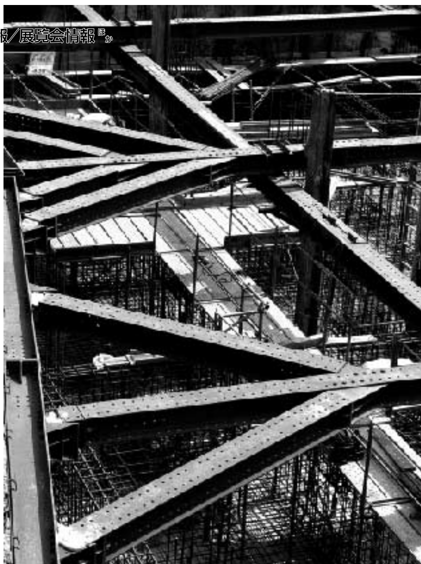
嵯峨校舎建設現場 20030912
