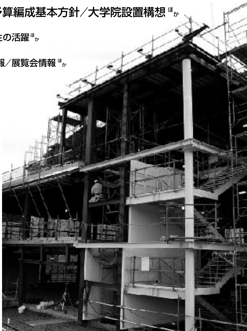
森原校舎建設現場20031215
