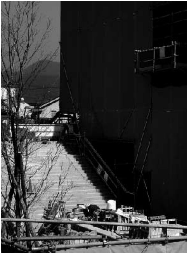
森原キャンパス「有響館」建設現場20040220
